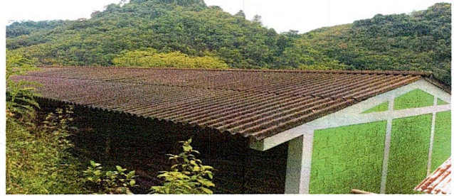
Foto 2: Edificio de tres Aulas
