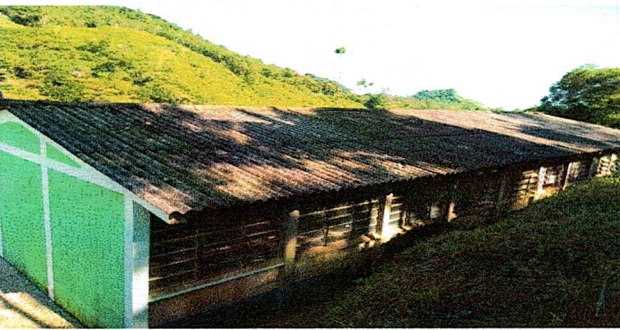
Foto 3: Sustitucion de techo
