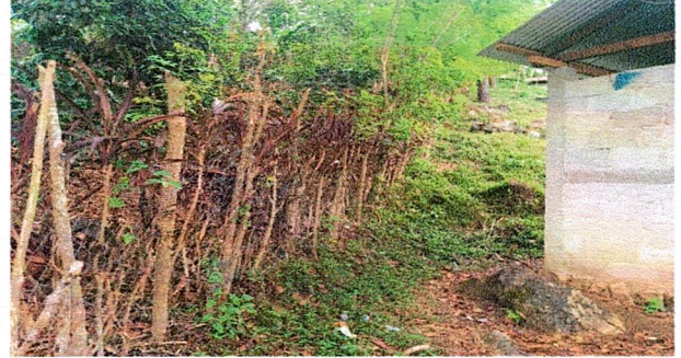
Foto 2: Parte del cerco perimetral al norte
