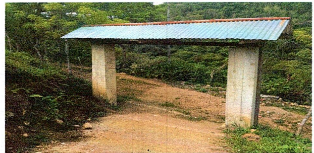
Foto 6: Colocacion de porton
