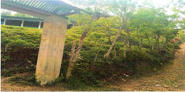
Foto 3: Sustitucion del cerco perimetral
